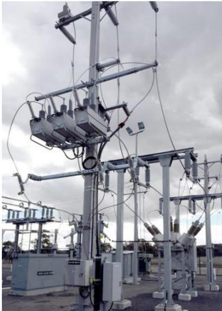
NOJA Power Religador OSM Single Triple com Tecnologia de Limitação Rápida de Corrente de Falta à Terra
